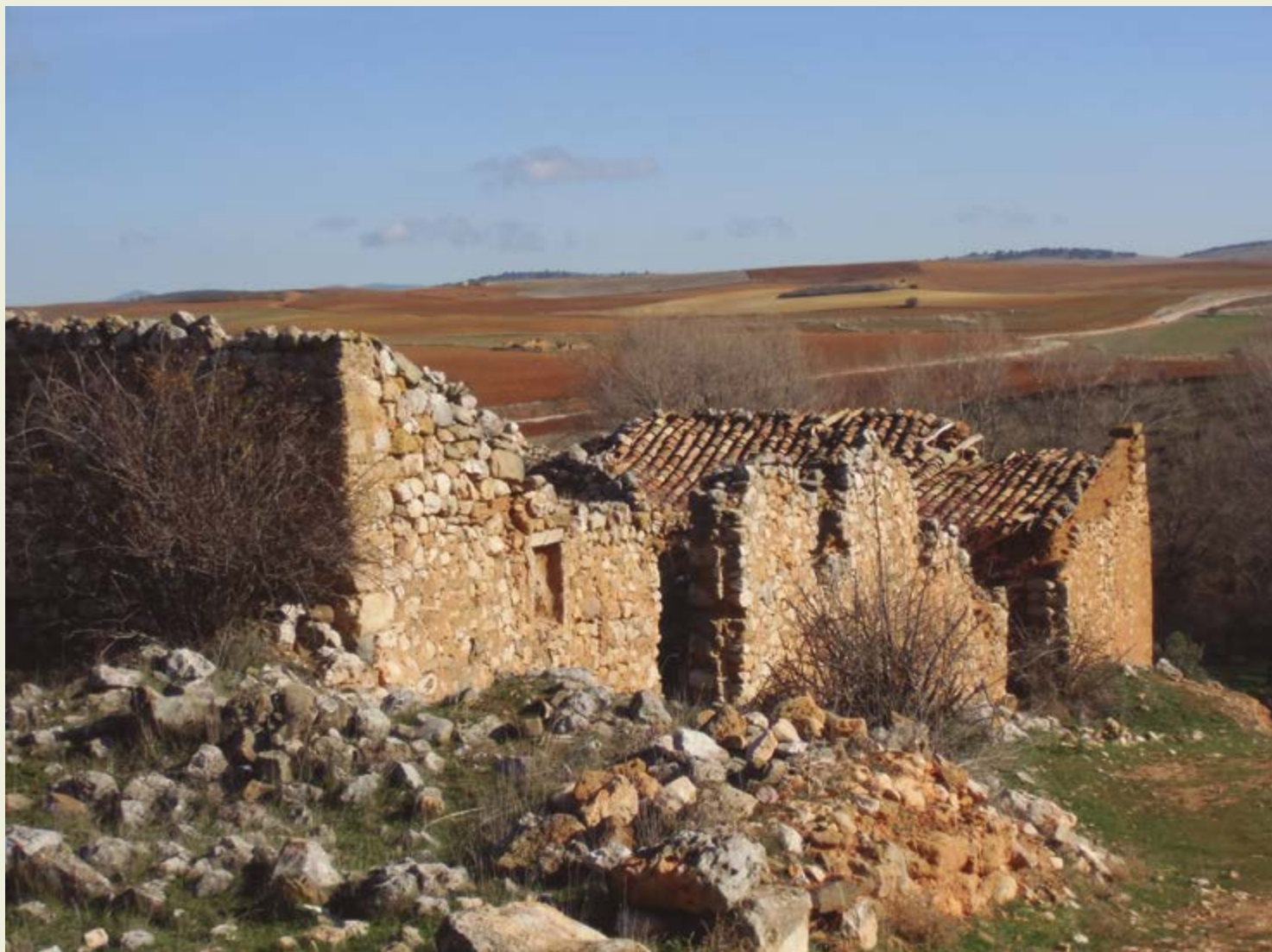
Edificios en ruinas (septiembre de 2011).
