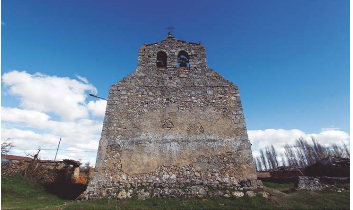
Figura 8: Espadaña utilizada como pared de frontón. Foto: Mario Tejedor
