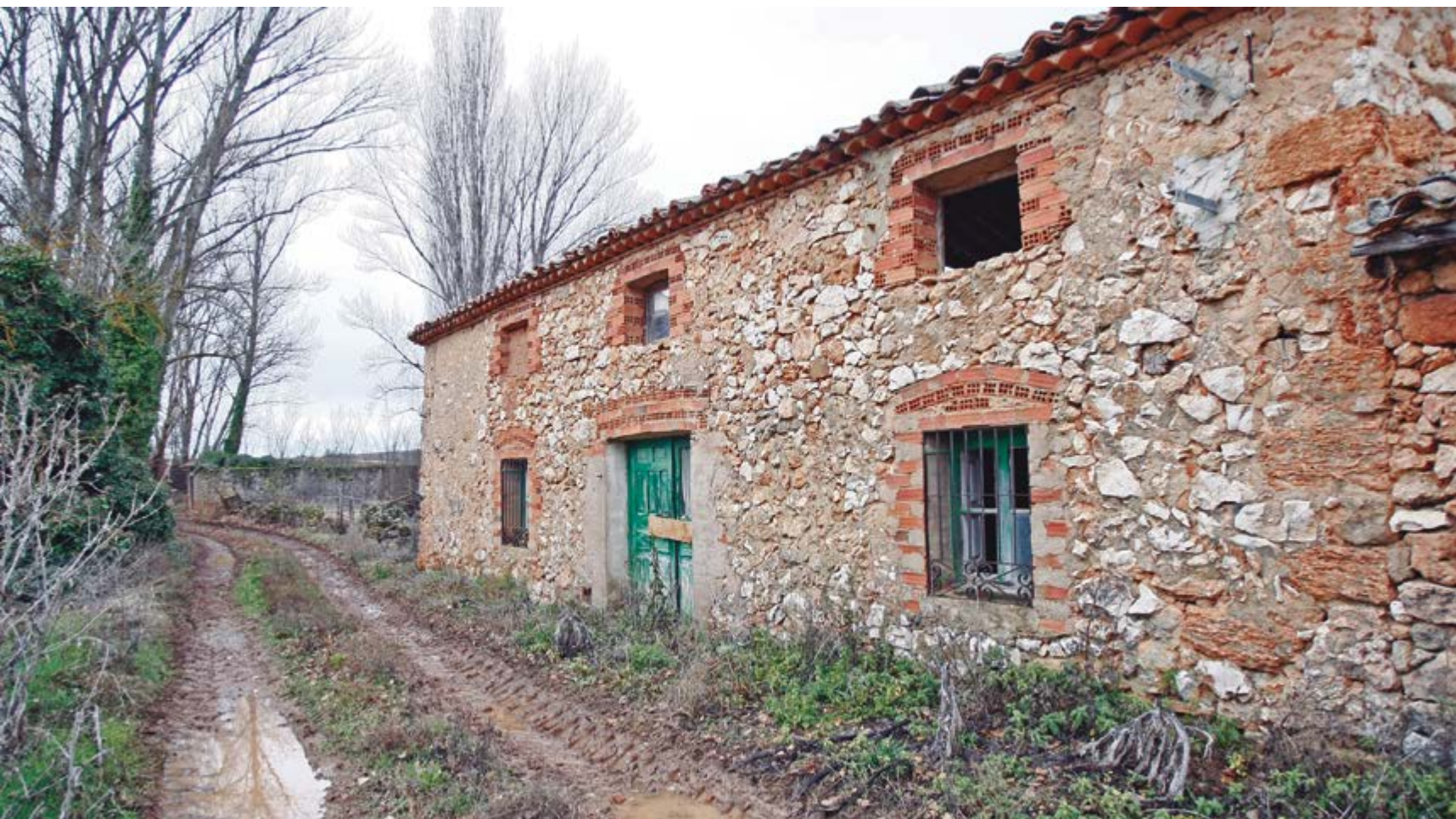
Figura 3: Vivienda con cementerio al fondo. Foto: Mario Tejedor
