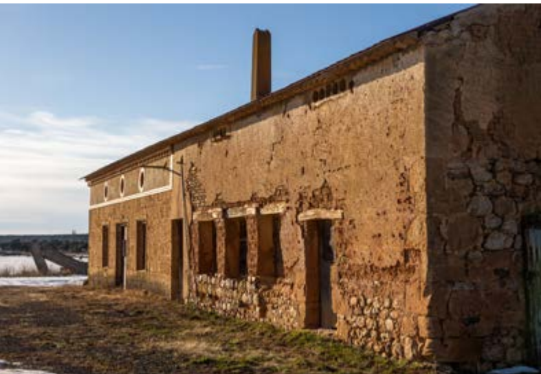
Construcciones en Baniel
