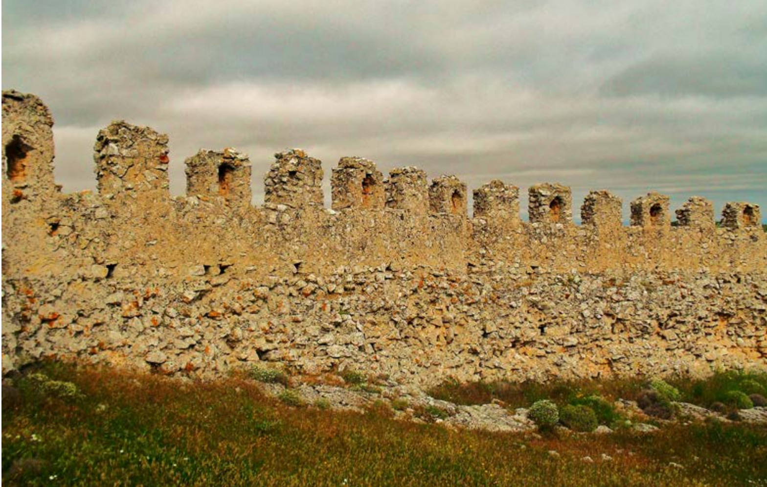
Muralla almenada, lado occidental
