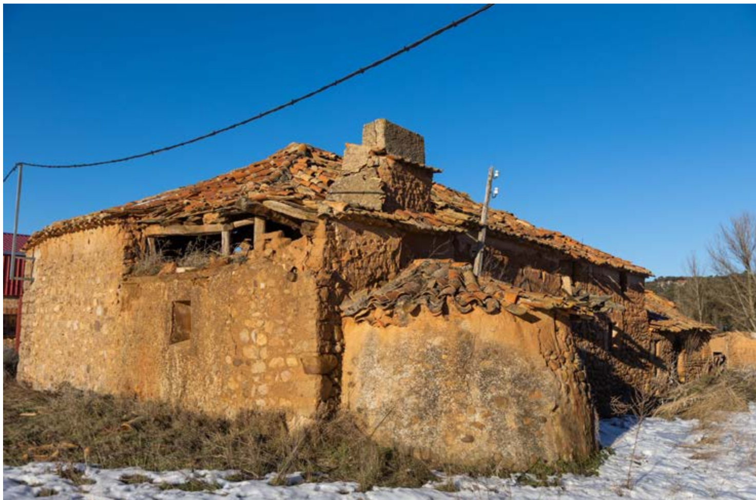
Vivienda con horno
