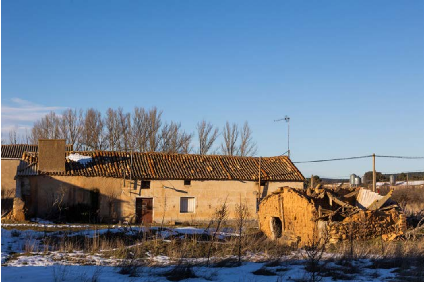
Construcciones en Baniel
