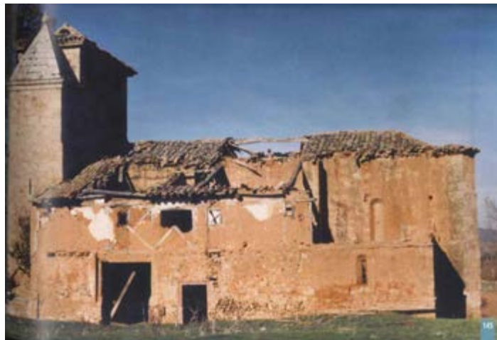
Iglesia de San Esteban antes de la reconstrucción
