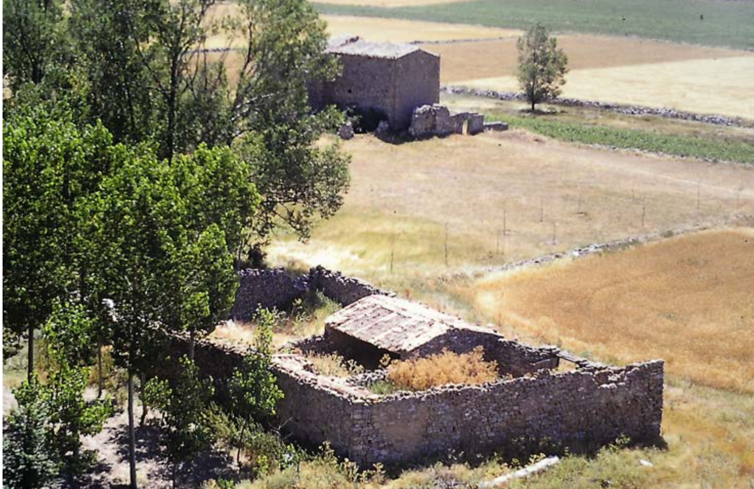
Construcciones y entorno de Masegoso
