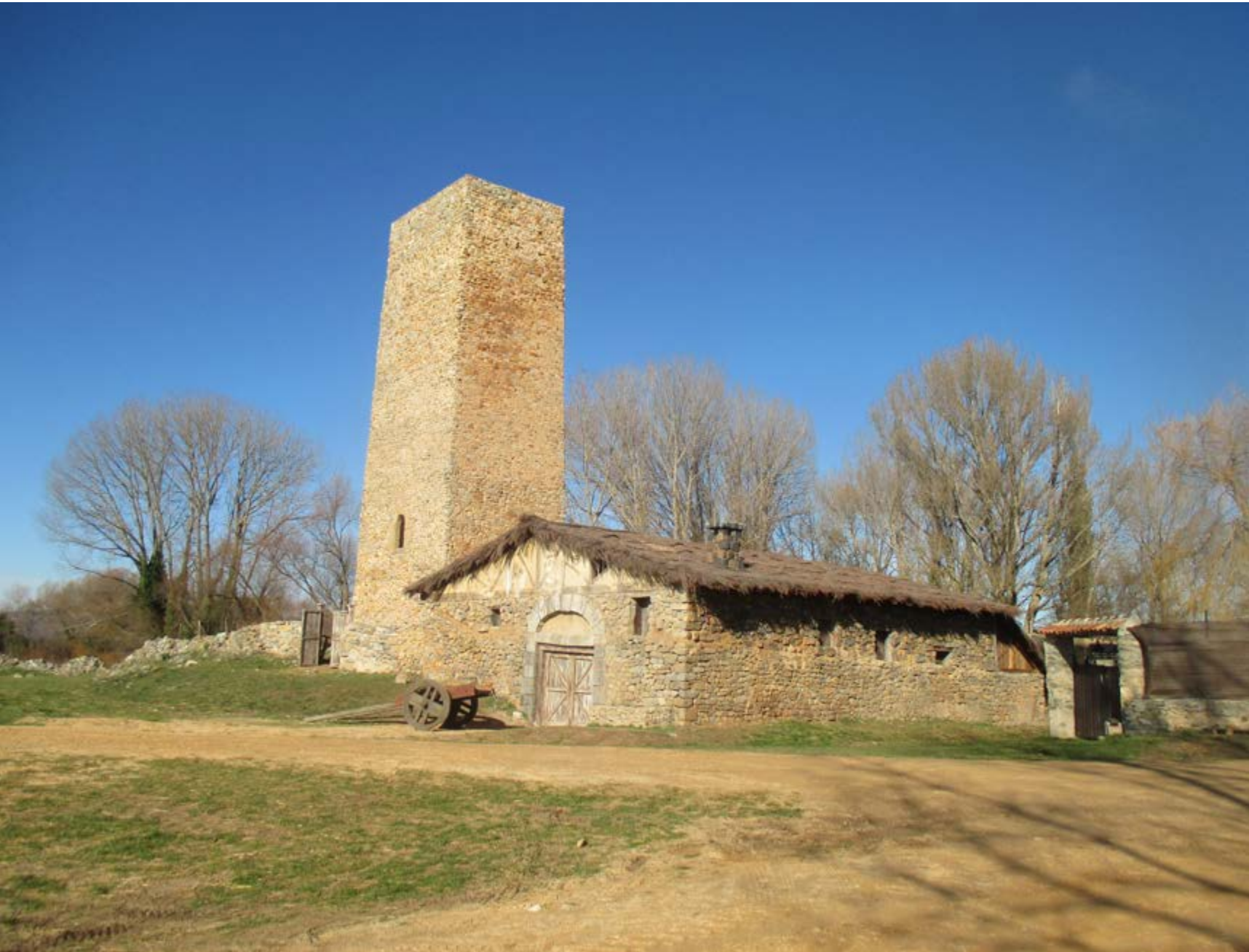
La torre de Masegoso con la reconstrucción de una casa para la serie El Cid, en 2020.
