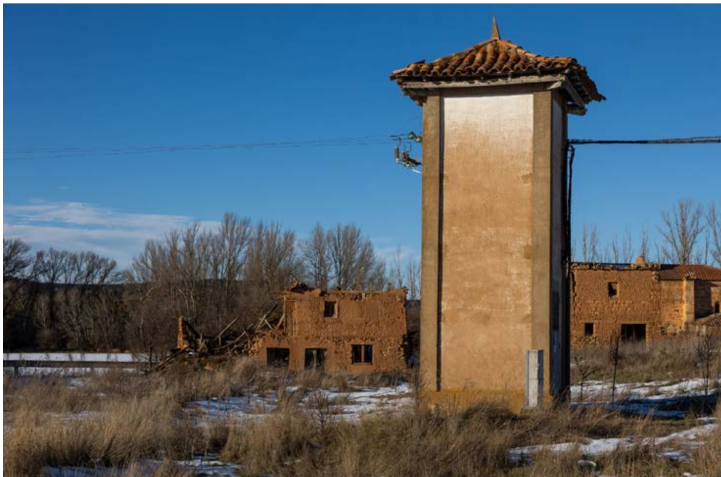
Transformador y restos de edificios
