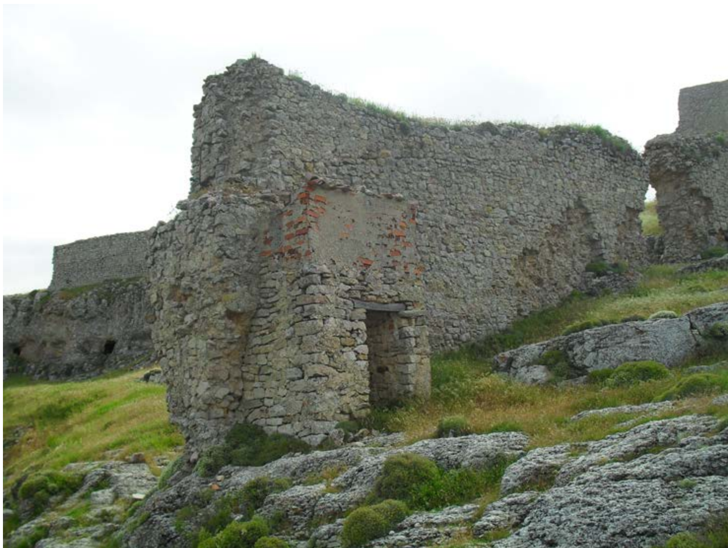
Antiguo transformador eléctrico junto a la entrada al despoblado
