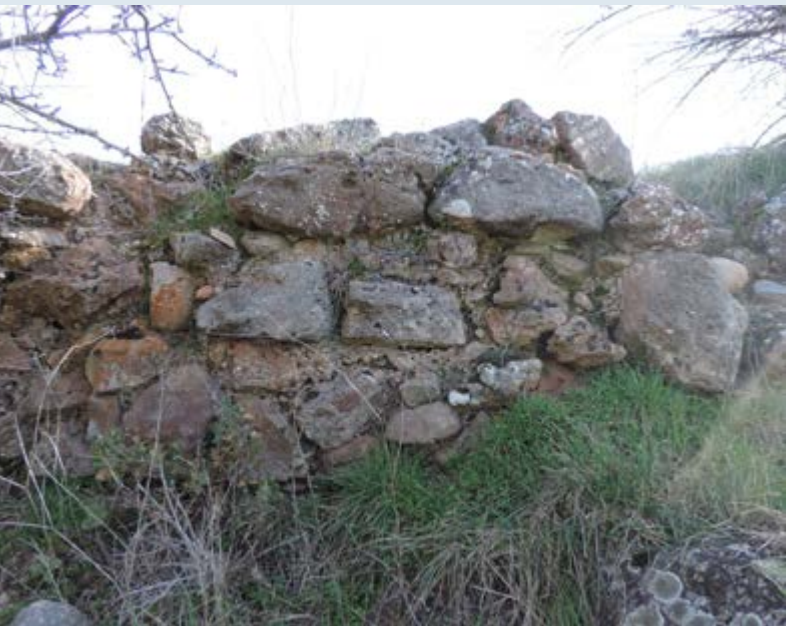
Restos del muro de la iglesia de Sotocarros
