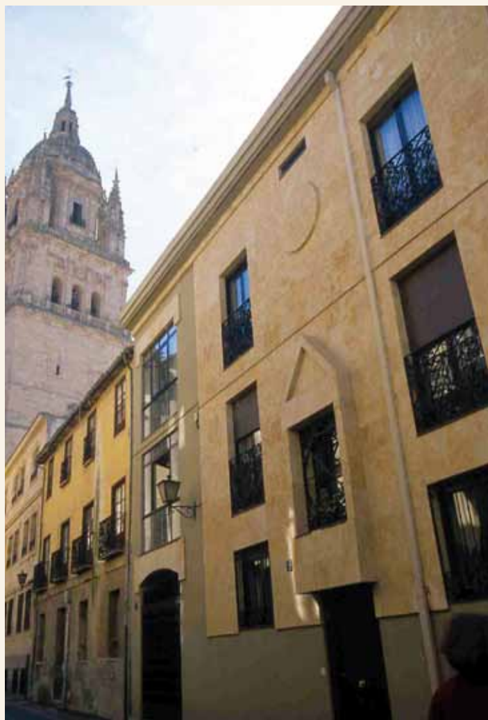
Salamanca: renovación residencial en el centro histórico.
